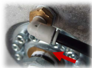
加圧ユニット側エアホースと貯水部の接続 加圧ユニット側エアホース接続 (拡大) 貯水部側エアホース接続 (拡大)
